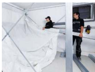
Einhängen des Silos
