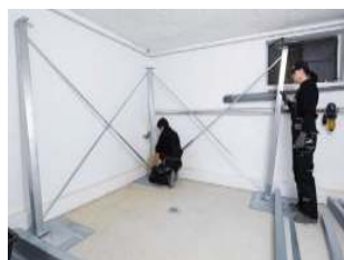
Aufbau des Stahlgestell's
